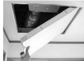
ファン本体設置の天井点検口を手で支えながら開き、フェース部分が見えるか確認します。
