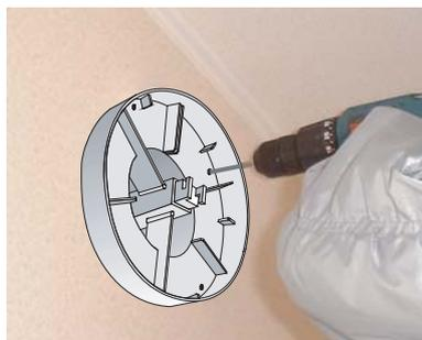
内装仕上げ施工終了後、リフレッシュ80の頭部と外ガラリーをビス止めします。外側はステンレスビスを使用し、コーキング処理します。
